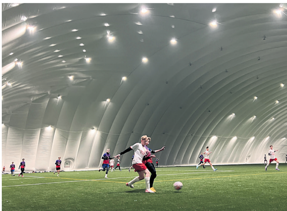
Powłoka pneumatyczna boiska składa się z systemu podwójnej membrany, a pomiędzy jej warstwy non stop włączane jest powietrze generowane poprzez system nadmuchowy zasilany prądem. Poszczególne elementy łączą 12 tysięcy mocowań punktowych
